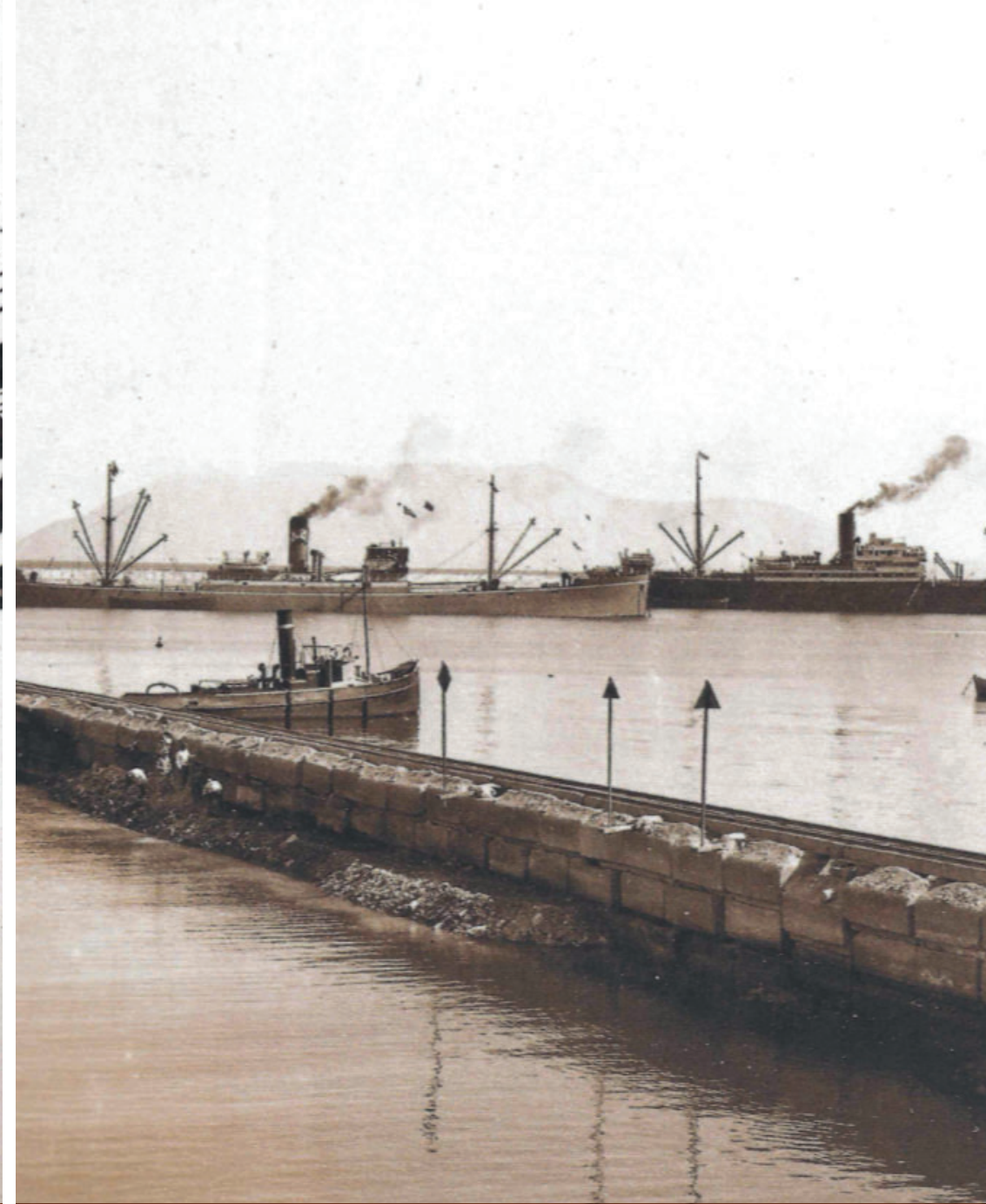
Estado de avance del Malecón anexo al Molo (Noviembre 1928)
