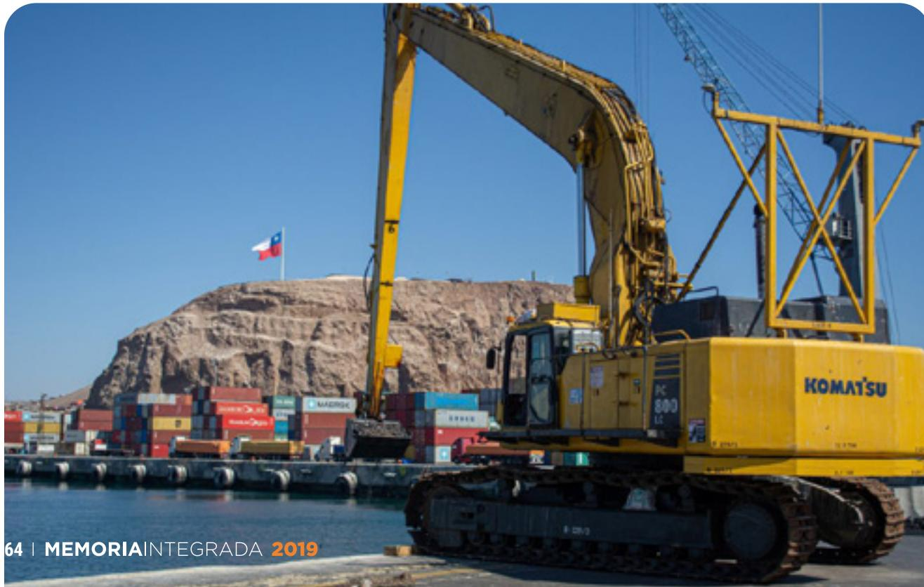
Por un lado, la profundización de los sitios 4 y 5 busca aumentar su calado actual de 10 metros a 11,4 metros. La obra implicará el retiro de material desde el fondo marino y la colocación de unas mantas de geotextil con concreto en el fondo marino para estabilizarlo. Una vez que estos trabajos finalicen, el Puerto de Arica quedará en condiciones de recibir barcos mayor capacidad, específicamente los Post Panamax Plus, y de itinerario directo desde Asia.
