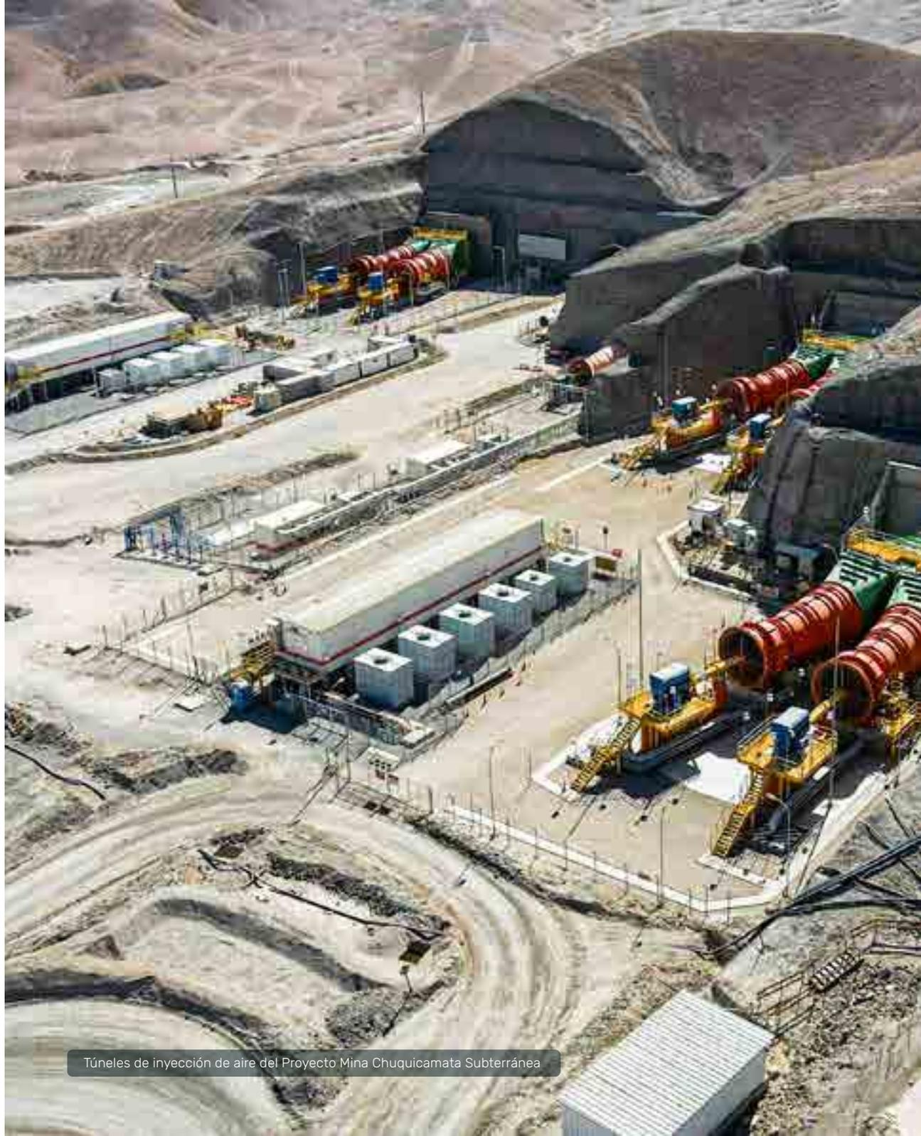
Túneles de inyección de aire del Proyecto Mina Chuquicamata Subterránea
