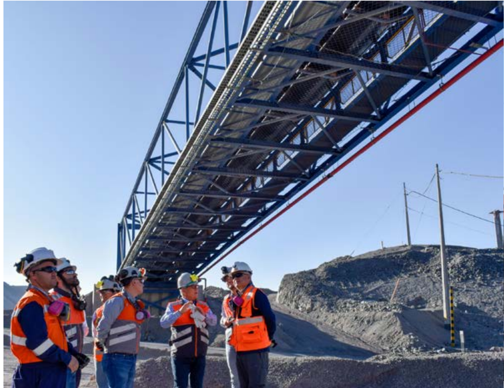
Correa de transporte de mineral, Chuquicamata Subterránea.
