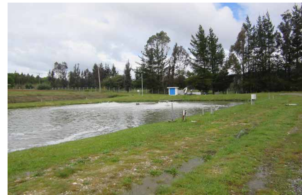
Operador: Aguas Araucanía Proyecto: Ampliación PTAS Capitán Pastene
