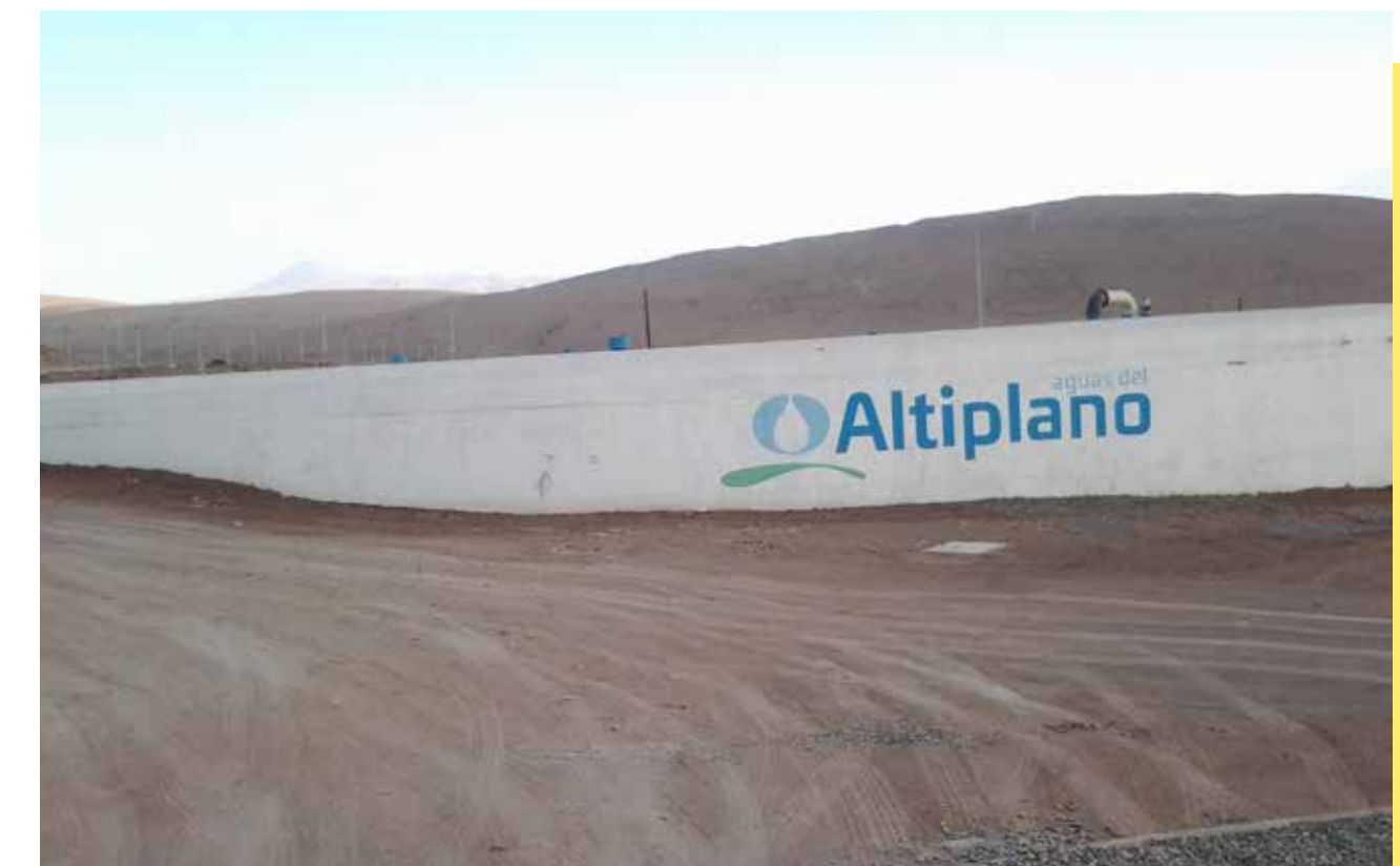
Operador: Aguas del Altiplano Proyecto: Estanque Santa Rosa
