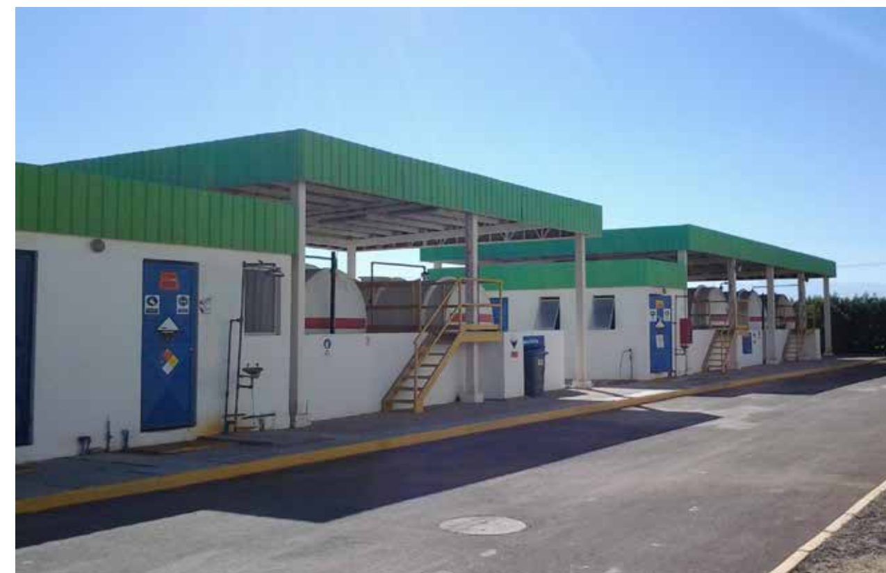
Operador: Aguas del Altiplano Proyecto: Ampliación PTAP El Carmelo
