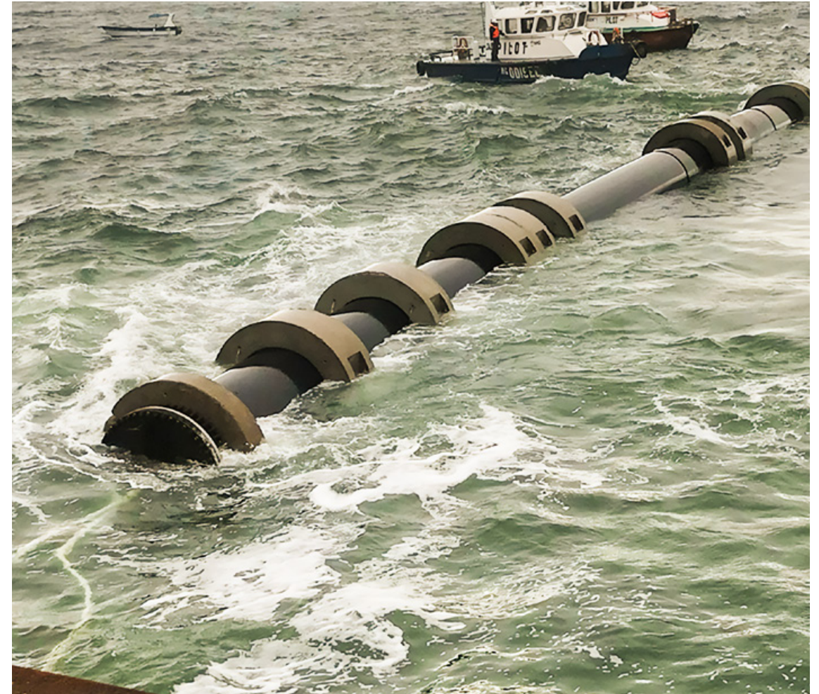
Descarga de emergencia, Antofagasta.
