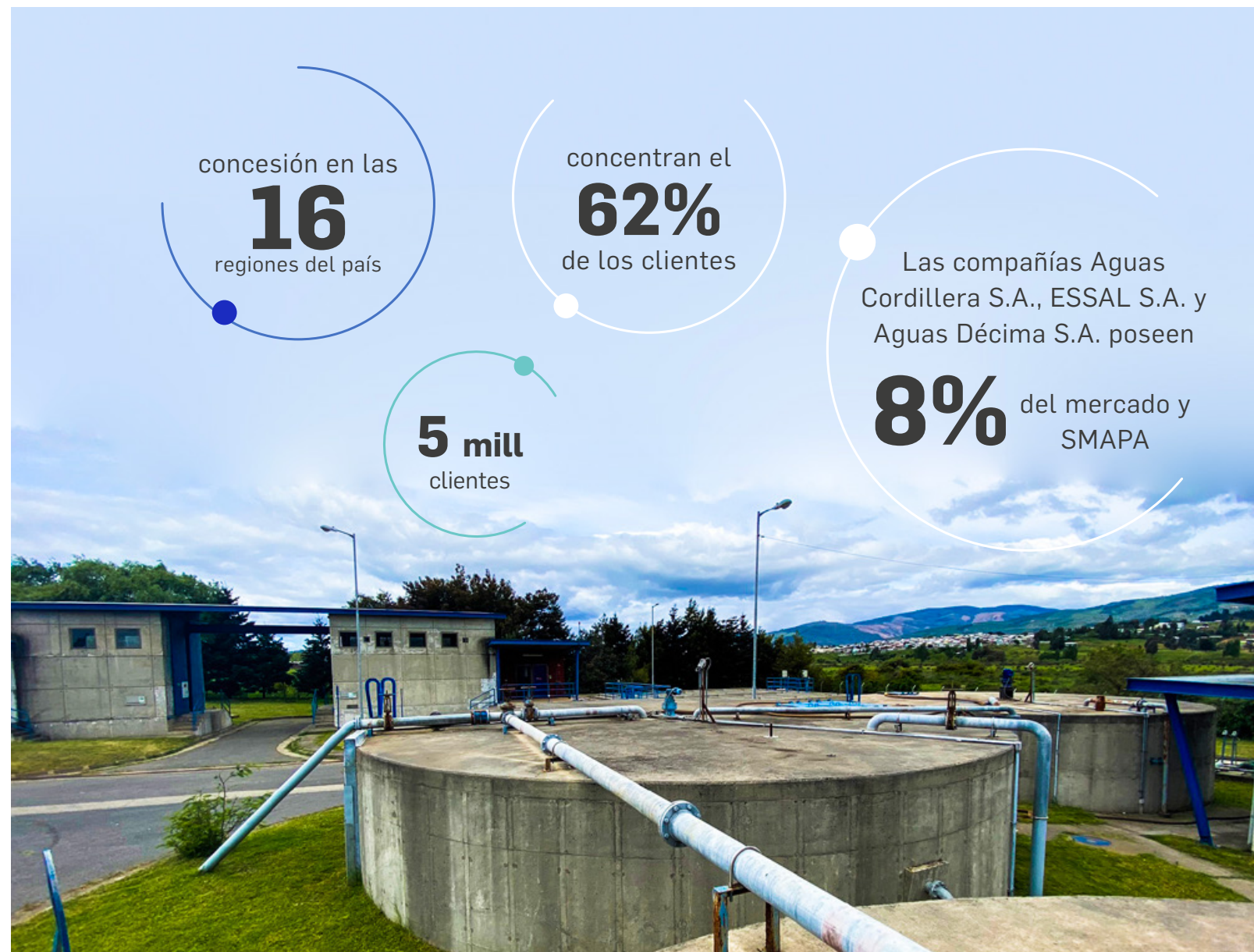
Planta de Tratamiento de Aguas Servidas (PTAS), Angol.
