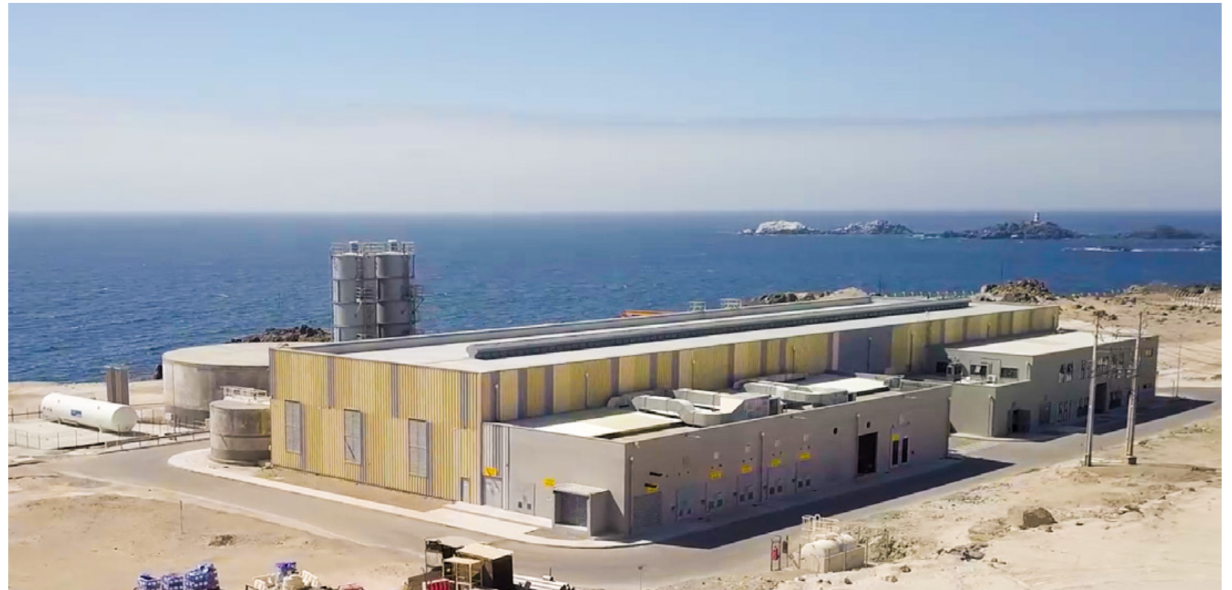
Planta Desalinizadora de Agua de Mar para la Región de Atacama (PDAM). Región de Atacama.
