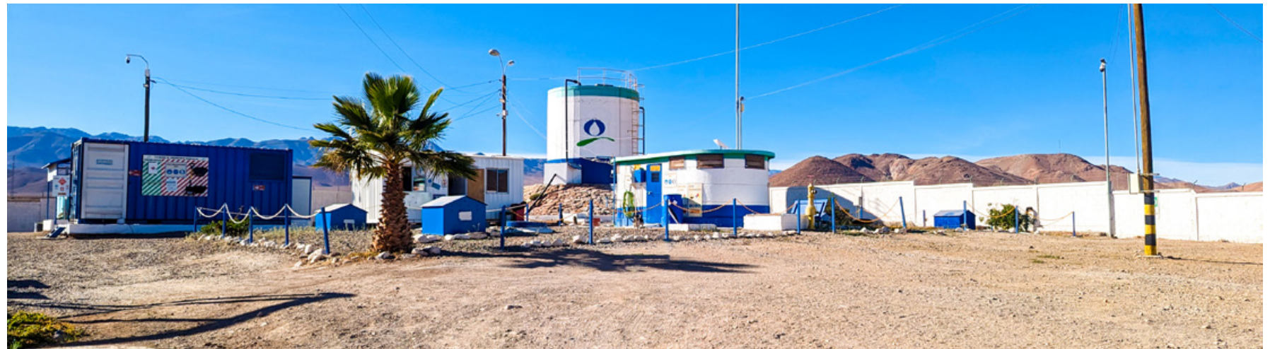
Planta de Tratamiento de Agua Potable (PTAP), Inca de Oro.
