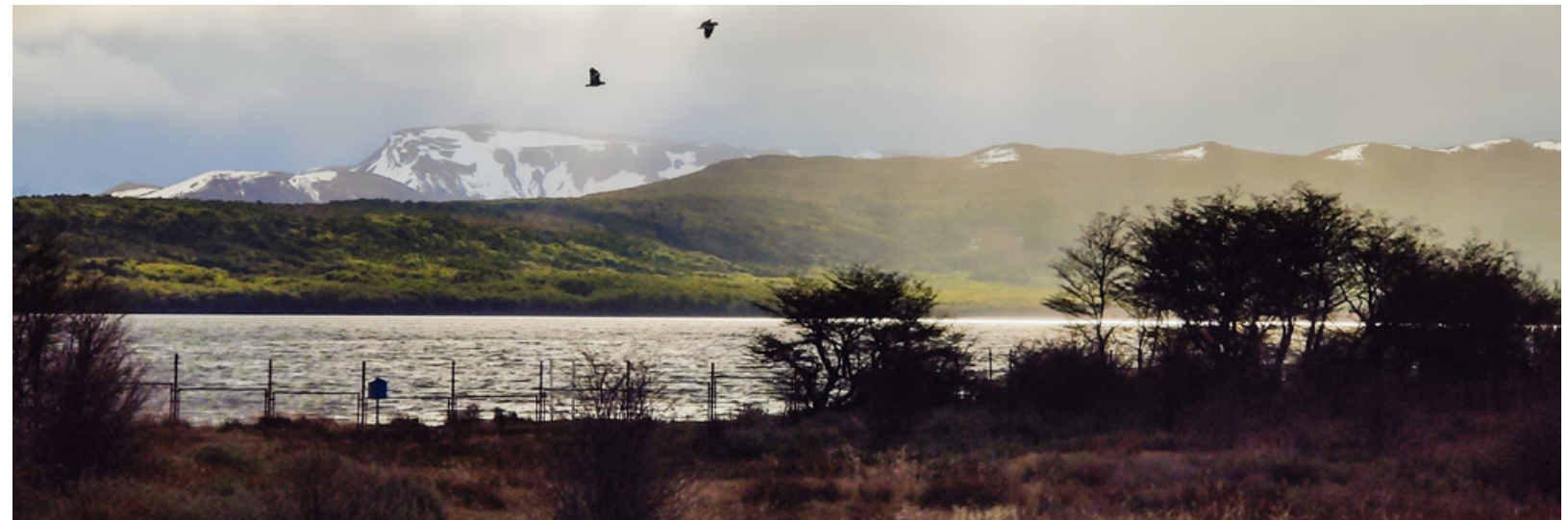
Planta Elevadora Agua Potable (PTAP Parrillar). Región de Magallanes y de la Antártica Chilena.
