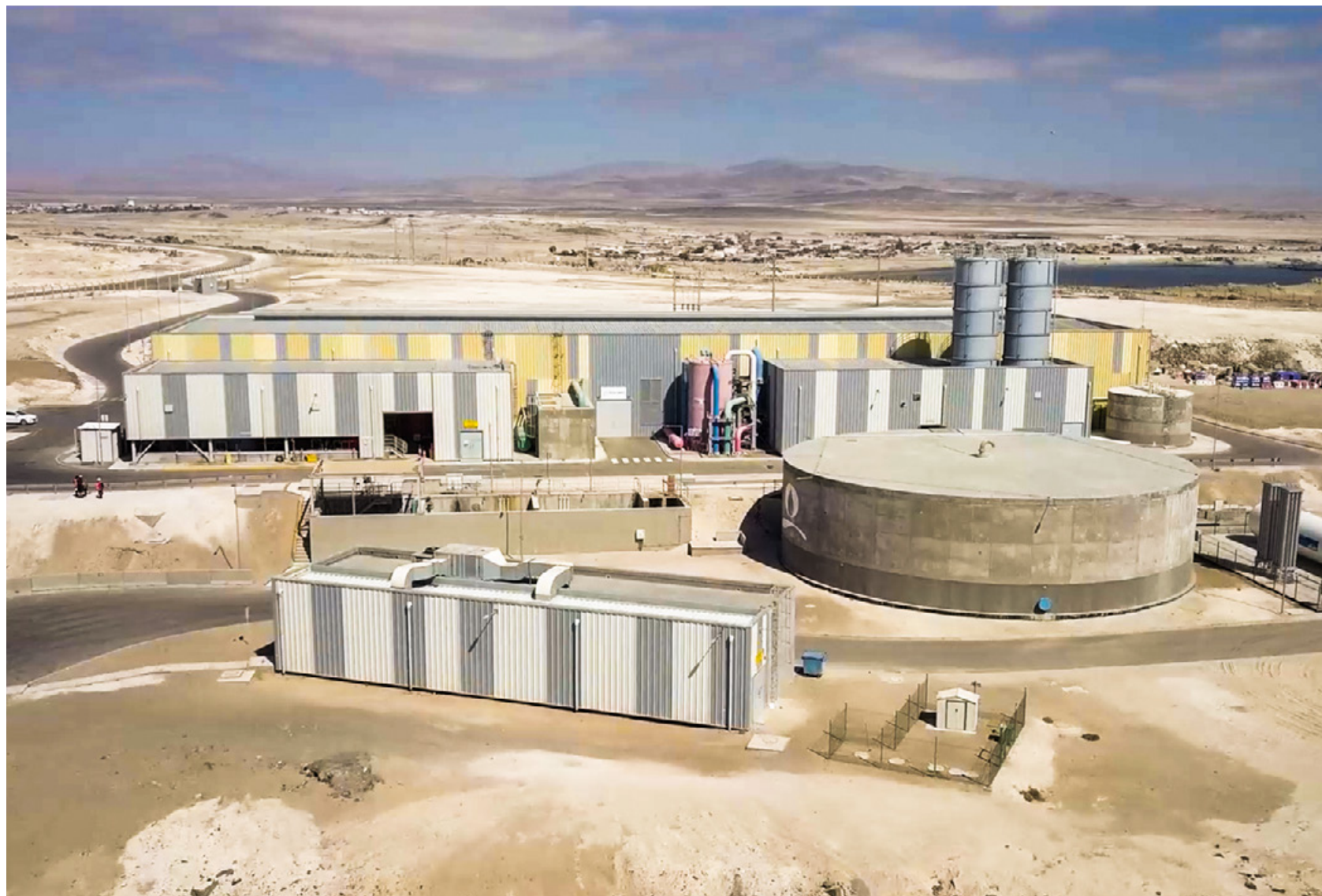
Planta Desalinizadora de Agua de Mar para la Región de Atacama (PDAM). Región de Atacama.
