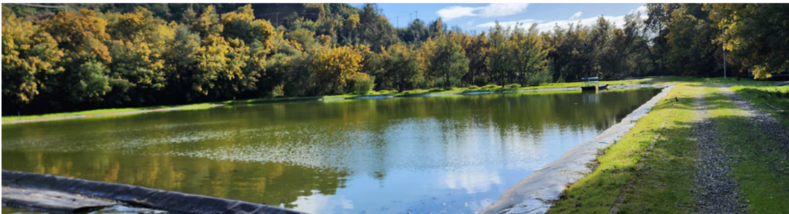
Planta de tratamiento de aguas servidas (PTAS), Mininco.
