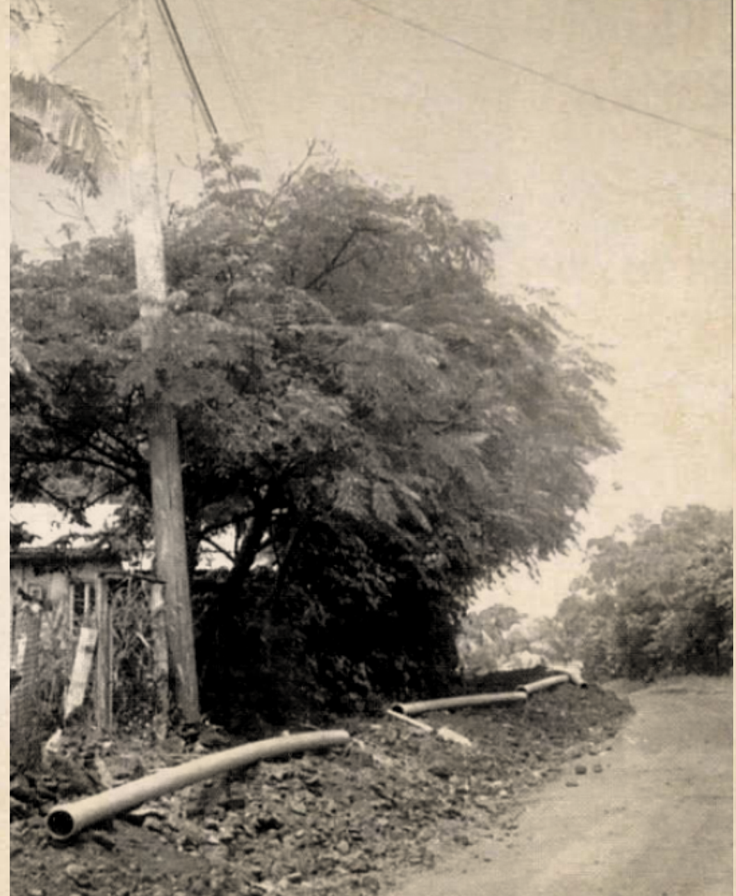
Trabajos de cambio de matriz de agua potable en Tu'u Ko Ihu
