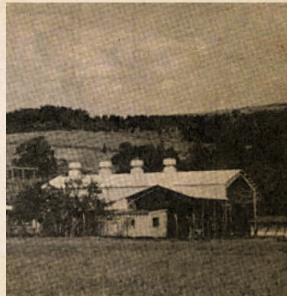
Central Eléctrica Mataveri
