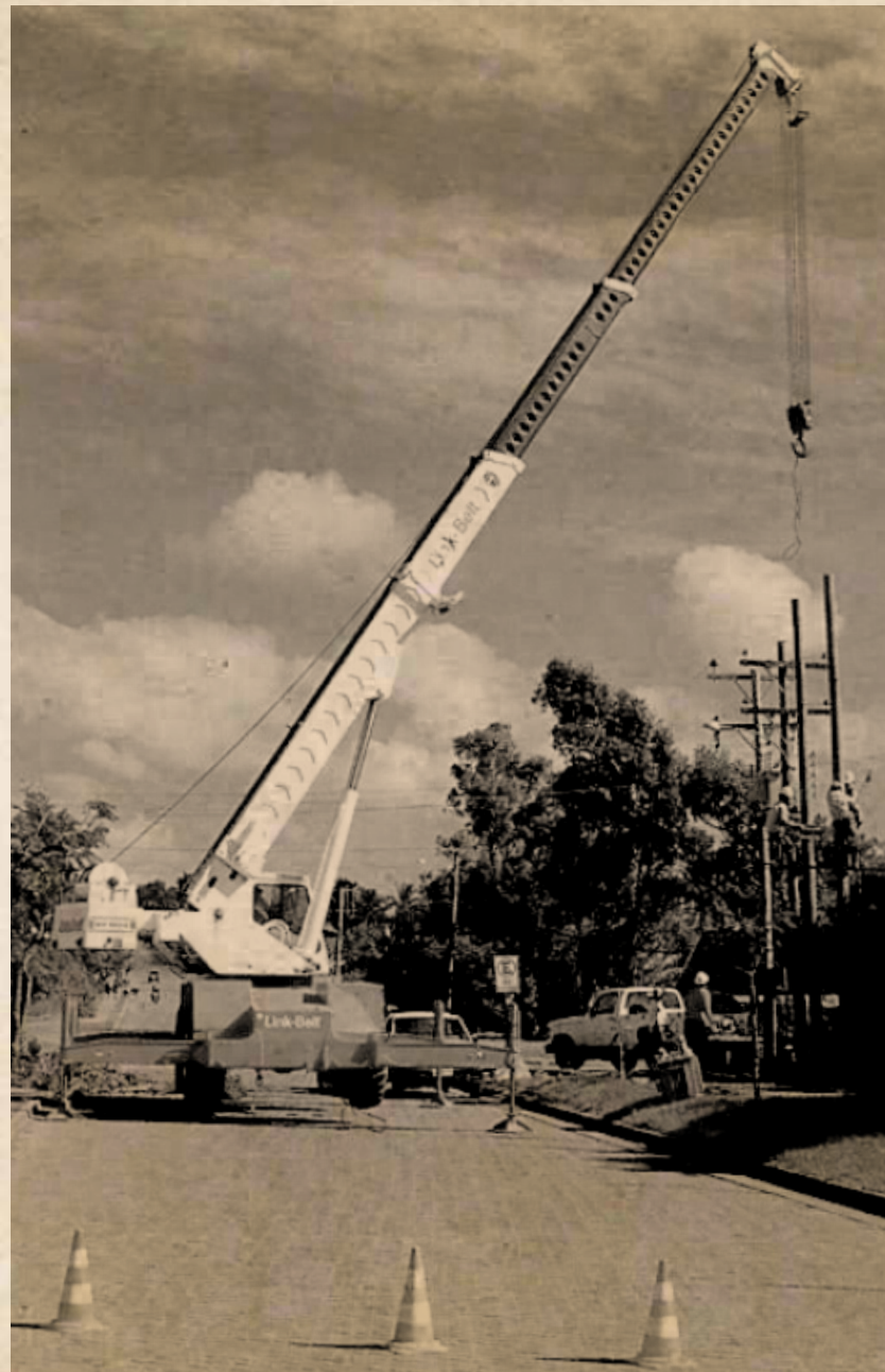
Instalación de transformador en calle Policarpo Toro 1992
