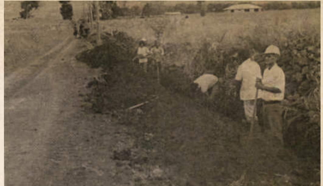
Trabajos de instalación de nueva matriz de agua potable 1990
