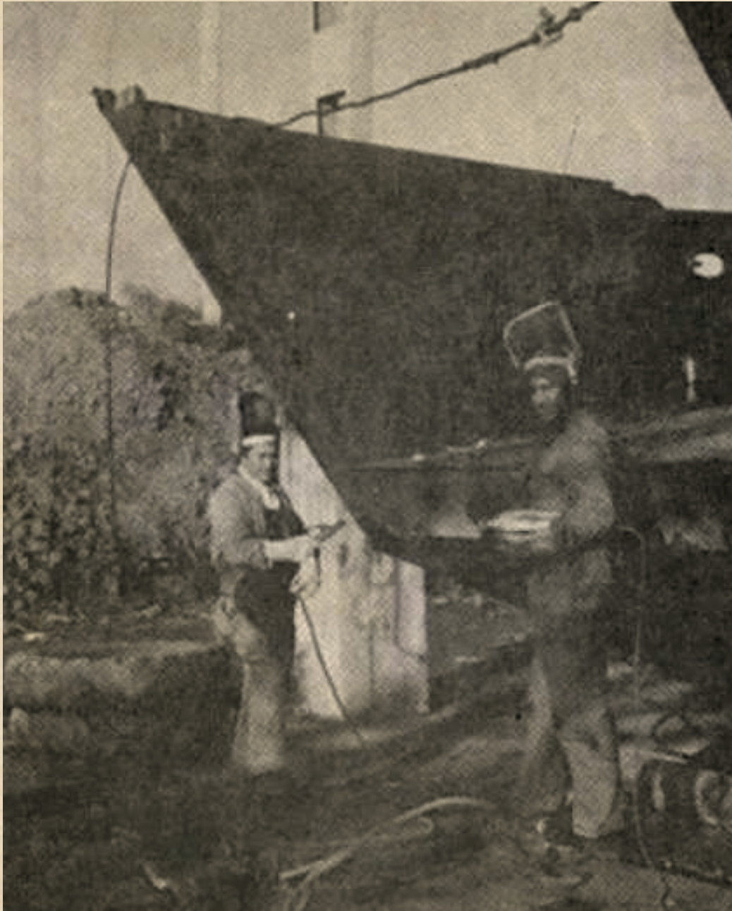
Trabajos de soldadura eléctrica en el casco de barcaza
