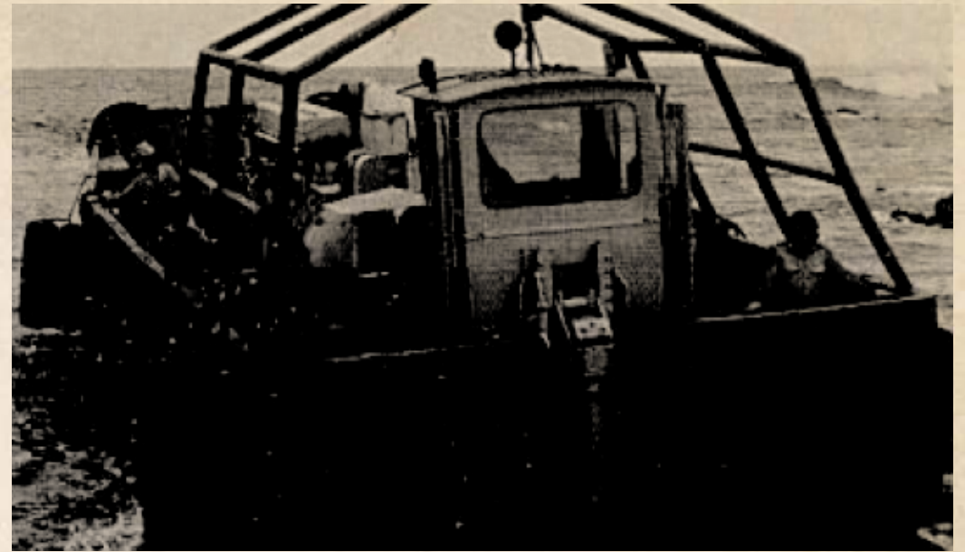
Generador en barcaza - 1992
