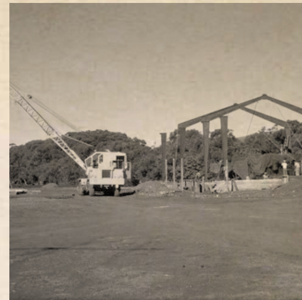
Construcción central eléctrica
