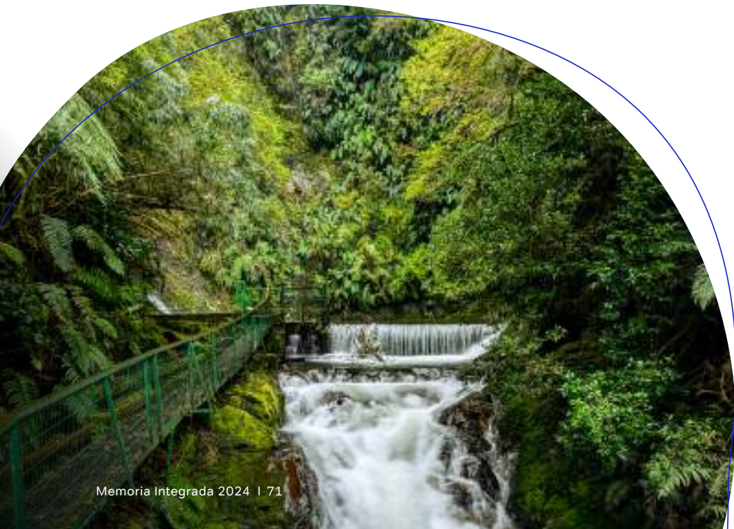
Captación de Estero San Luis, Puerto Cisnes.
