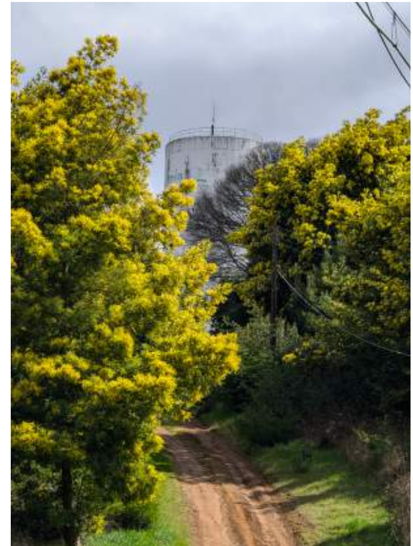
Planta de tratamiento de agua potable (PTAP), Ercilla.
