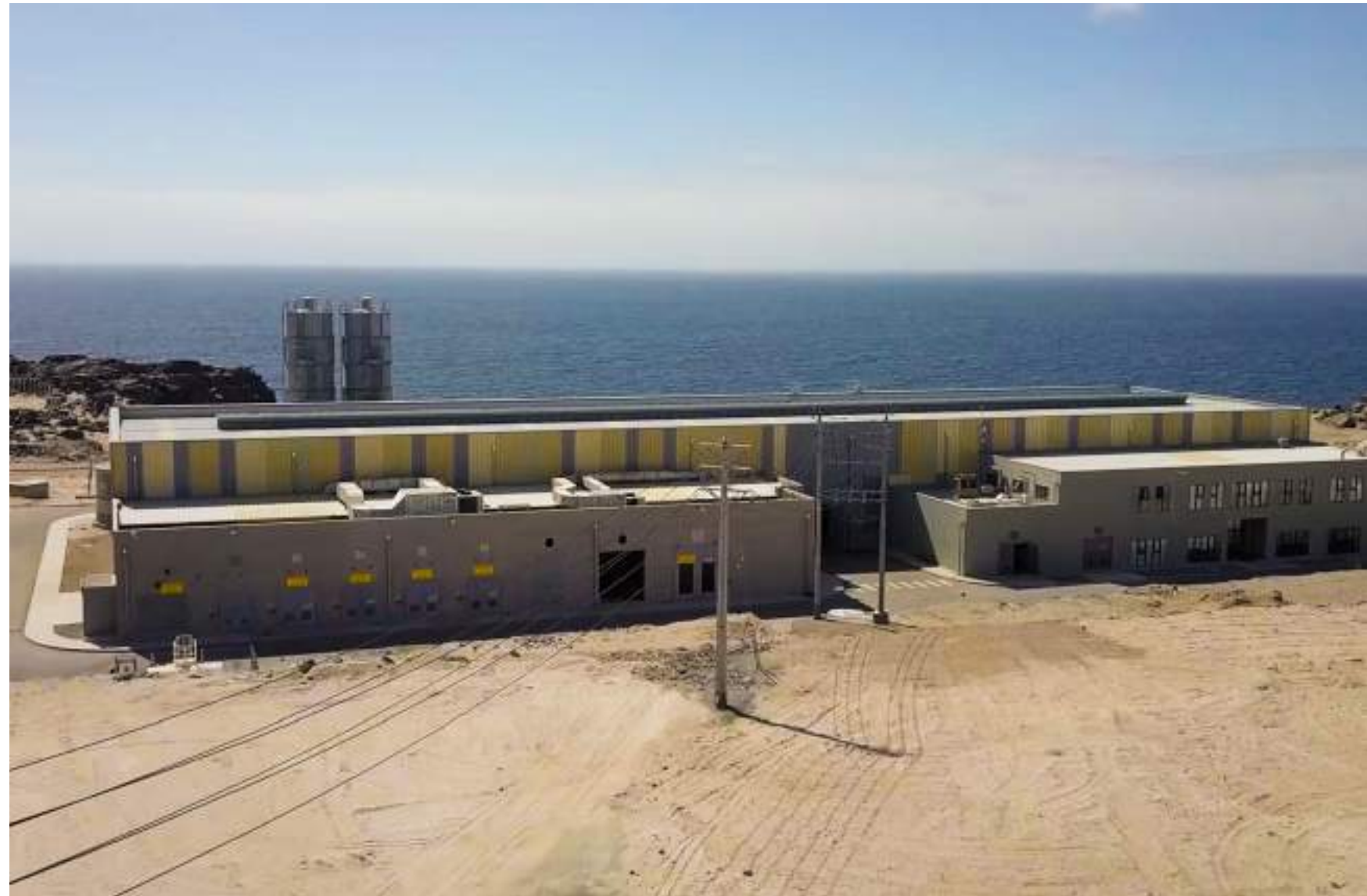
Planta desalinizadora de agua de mar (PDAM), Atacama.
