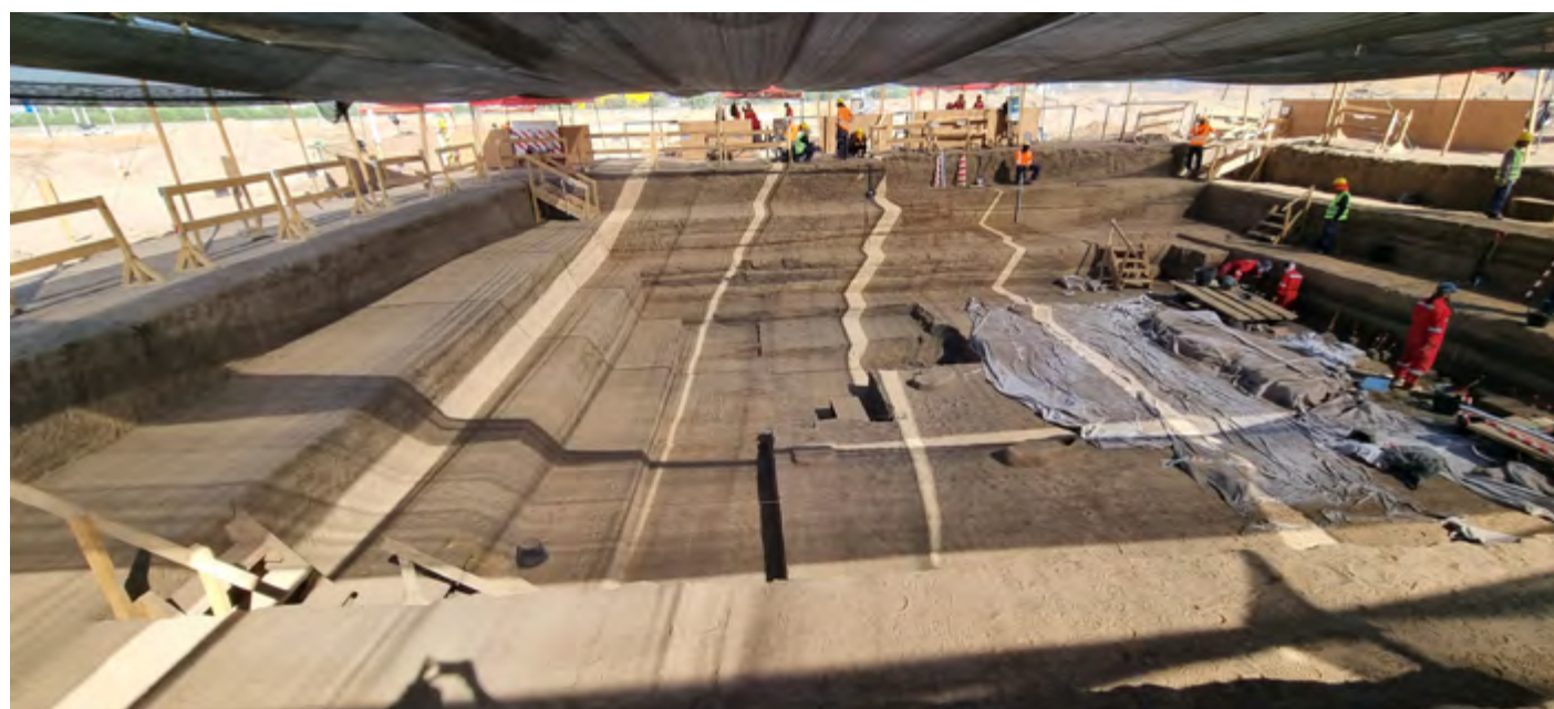
Excavación ubicada en el sector "B" de Talleres y Cocheras Línea 7
