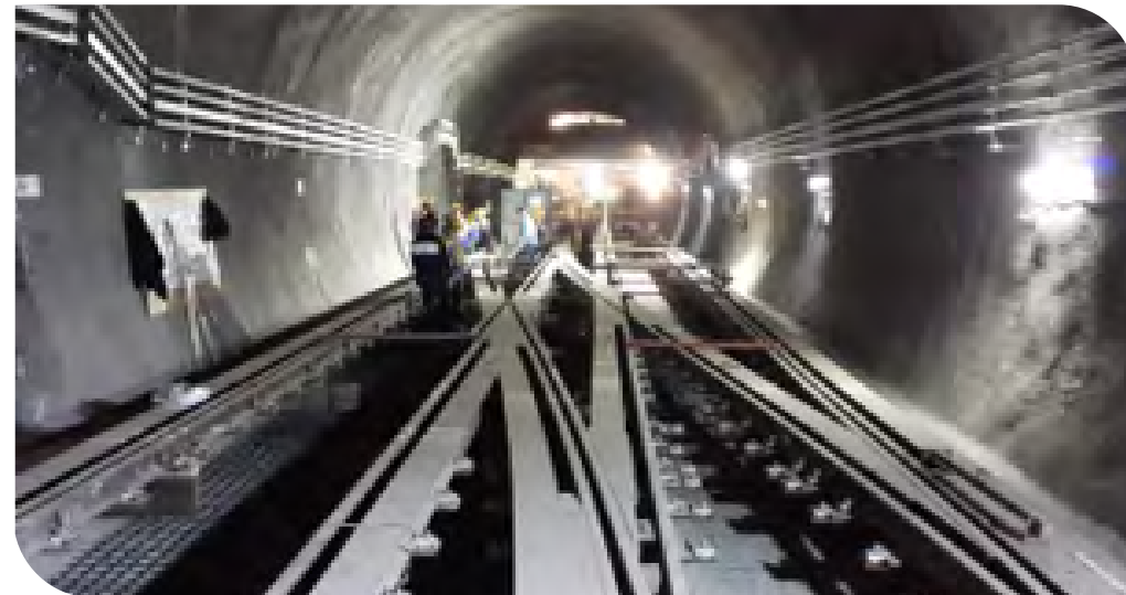
Instalación aparato de vías previo - E. El Pino
