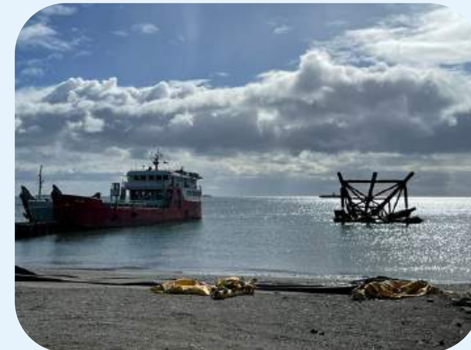
Estructura jacket Dolphin Nro. 3, lista para ser trasladada a Terminal Prat
